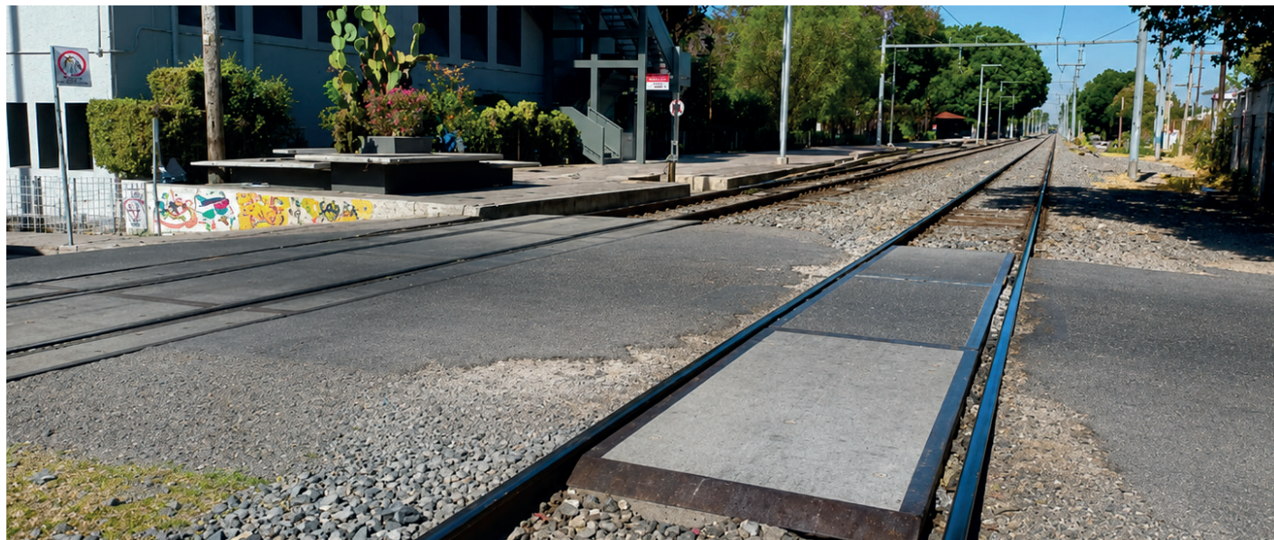
Figura 1. Cruce a nivel ubicado en una zona urbana.
